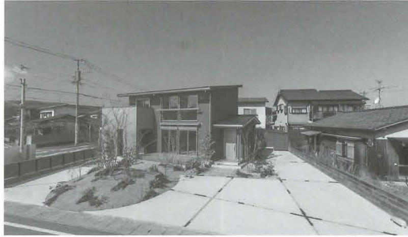
今年3月に福岡県春日市にオープンさせる次世代住宅モデルハウス「棲香(SUMIKA)」。U A 値0.44W/m 2 ・Kの外皮性能を持ち、屋根一体型のPV11.88kWを搭載する。HEMSによるエネルギー管理も可能だ
