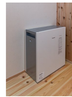
5.6kWhのリチウムイオン蓄電池
