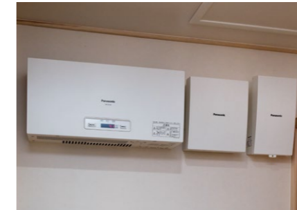
太陽光発電用パワーコンディショナと接続箱
