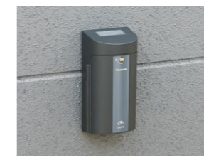
標準採用されているEV充電用屋外コンセント
