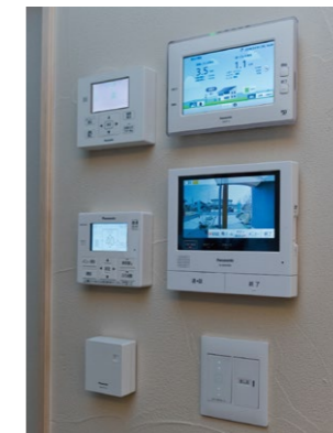
AiSEG2、どこでもドアホン(右上)などはキッチン横の壁面にまとめられている
