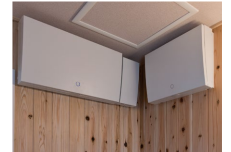
回路ごとの消費電力が把握できるスマートコスモ(左)と停電時に特定負荷に給電する電力切替ユニット
