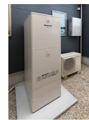
壁掛けタイプのパワーステーションS(右上)とエコキュー
