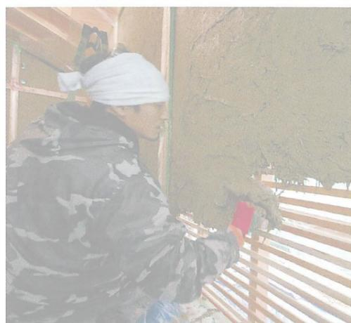
伝統的な「竹小舞・両面塗り」を「木小舞・土片面塗り」に変更し、必要な断熱材を充填する工法(提供:トヨタヤスシ建築設計事務所)
