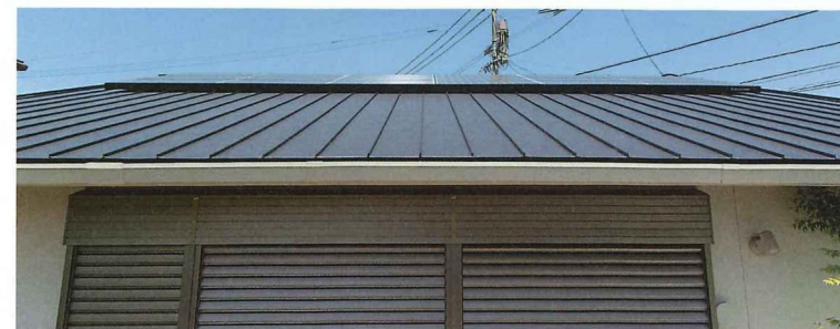
〔写真4〕4.14kWの太陽光発電パネルを設置 屋根に設置した太陽光発電パネル。容量は4.14kW。緩勾配で片流れの屋根形状なので、パネルの存在は目立たない
