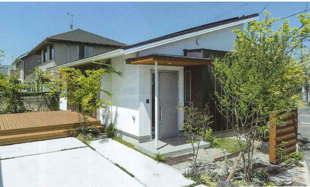
〔写真2〕築40年以上の住宅をリノベーション 東側から見た外観。築40年以上の住宅をスケルトン状態にしてリノベーションした。経済産業省の「ZEHロードマップ検討委員会」が示したZEHの判断基準を満たす省エネ性能を実現した
