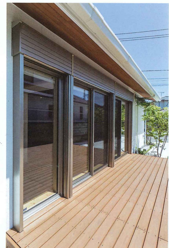
外付けブラインドで日射をコントロール 茶の間南側の開口部。日射取得量は外付けブラインドでコントロールする。浴室など水回りはトリプルガラスだが、茶の間開口部は複層ガラス
