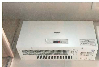
太陽光発電のパワコンには、停電時などに電気が使えるコンセントがついている。別途工事により壁などに非常用コンセントを設けることもできる(写真:エコワークス)
